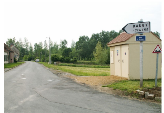
Une entrée de village à aménager
