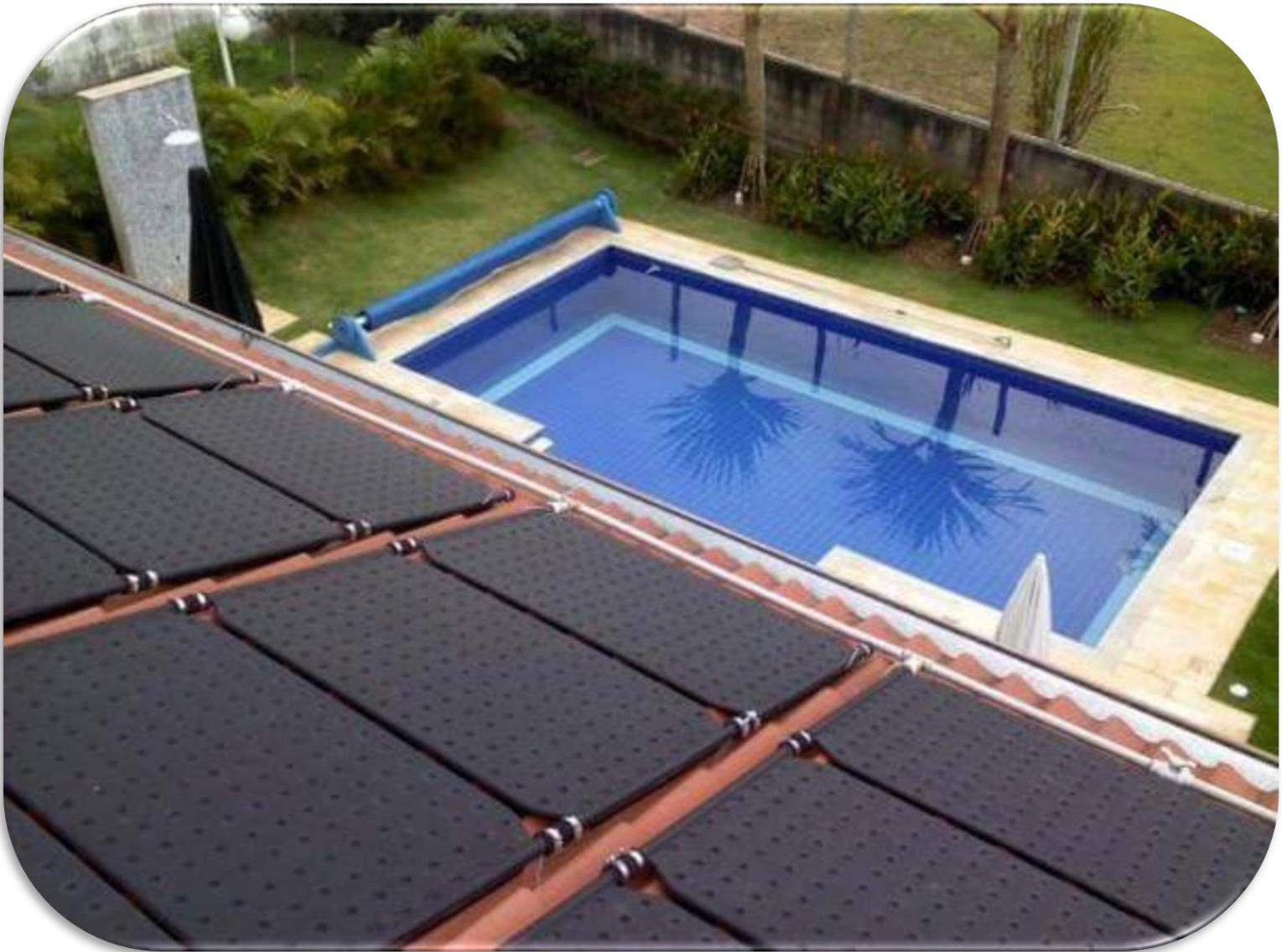
L'énergie solaire thermique est une énergie renouvelable consistant à produire de la chaleur ou de l'eau chaude à partir de capteurs solaires. Elle se distingue du solaire photovoltaïque qui produit de l'électricité à partir du rayonnement solaire.
